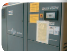
Nouveau compresseur à vis à vitesse variable
