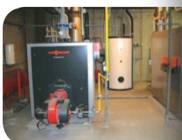
Installation solaire du site
