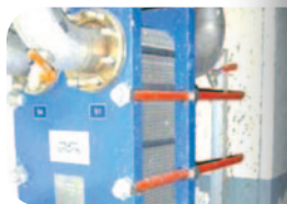
Echangeurs à plaques
