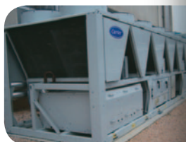
Nouvelle centrale de production de froid
