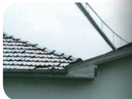
Calorifugeage des tuyaux
