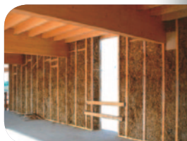
Vue interne du bâtiment
