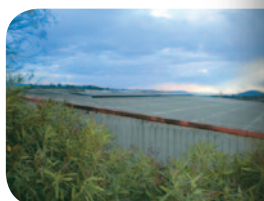
Panneaux solaires de production d'eau chaude
