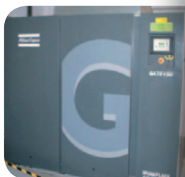
Compresseur à VEV
