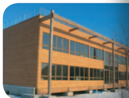
Vue externe du bâtiment
